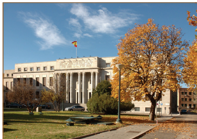
Edificio central del CSIC en Madrid
